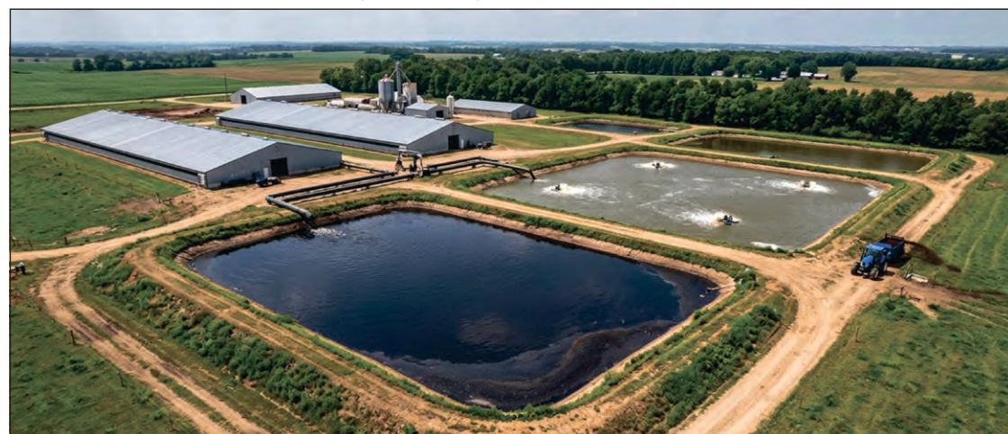
A piggery effluent pond.
